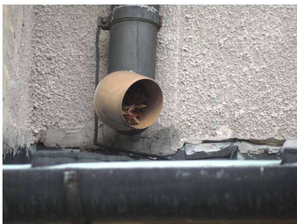
Fot. nr 17, 18. Zakończenie rury spustowej na dachu pulpitowym
