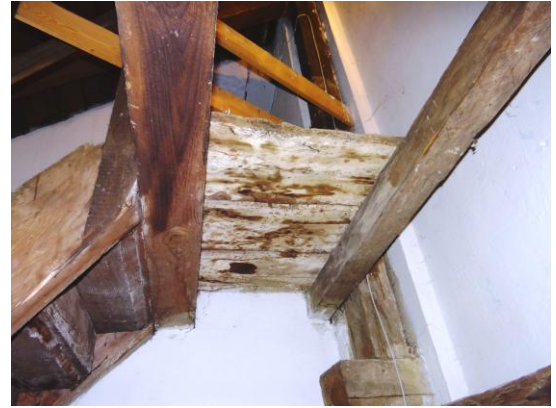
Fot. nr 22. Schody na chór. Widok od spodu butwiejącego podestu.
