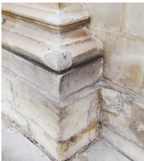
Fot. nr 29. Zwieńczenie cokołu – ubytek kamienia wypełniony zaprawą cementową, Dołem kamień zwietrzały.
