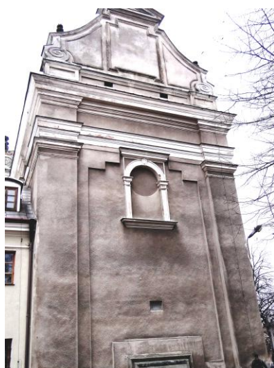
Fot. nr 7 i 8. Elewacja północna. Efekt wizualny niedbale położonych tynków
