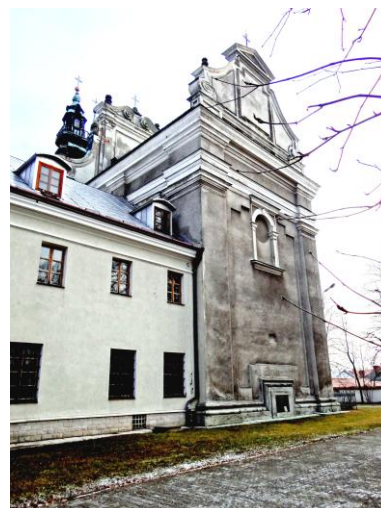
Fot. nr 7 i 8. Elewacja północna. Efekt wizualny niedbale położonych tynków
