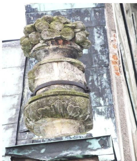
Fot. nr 29. Zwieńczenie cokołu – ubytek kamienia wypełniony zaprawą cementową, Dołem kamień zwietrzały.
