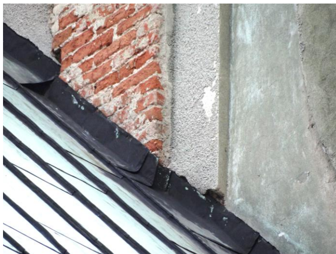
Fot. nr 14. Styk ściany szczytowej z blachą pokrycia dachowego.
