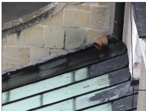
Fot. nr 17, 18. Zakończenie rury spustowej na dachu pulpitowym
