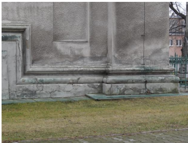
Fot. nr 1. Elewacja zachodnia. Fragment cokołu
