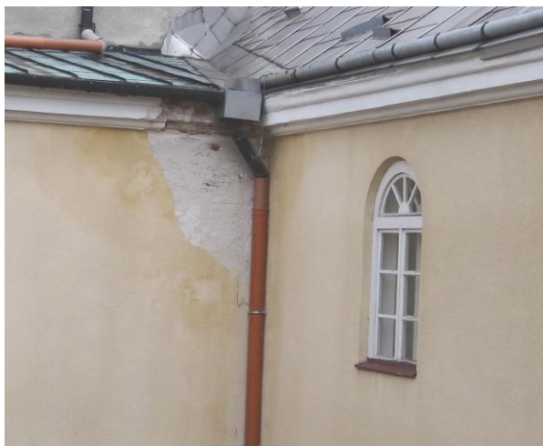
Fot. nr 6. Fragment elewacji wschodniej.
