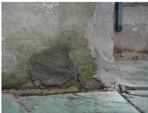
Fot. nr 3. Elewacja zachodnia. Fragment cokołu
