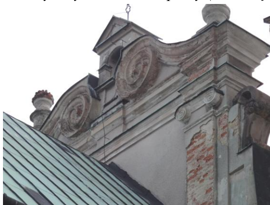
Fot. nr 4. Fragment ściany fasadowej widziany od strony połaci dachowej (od strony zachodniej)
