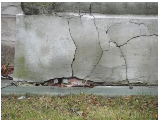
Fot. nr 2. Elewacja zachodnia. Fragment cokołu
