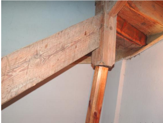
Fot. nr 22. Schody na chór. Widok od spodu butwiejącego podestu.
